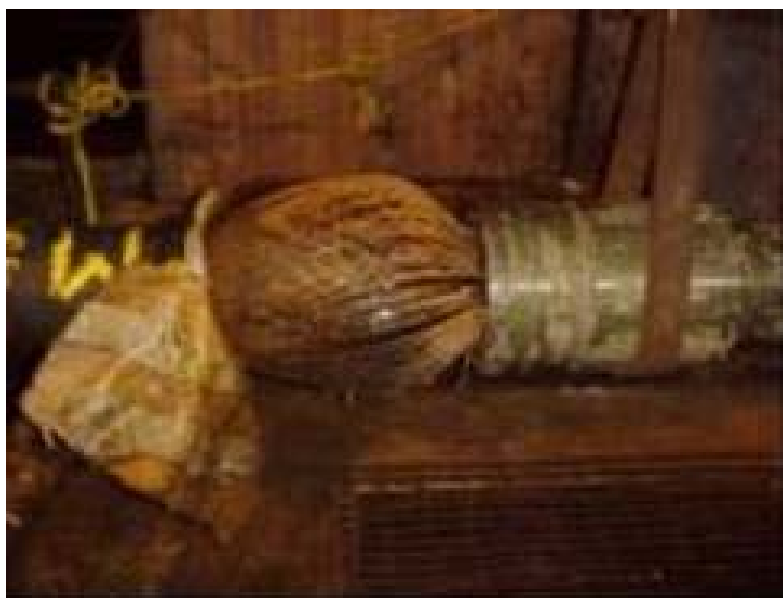
Figura 1.21: Gaiola de passarinho ou “birdcaging” Fonte: Visita técnica, 2008
