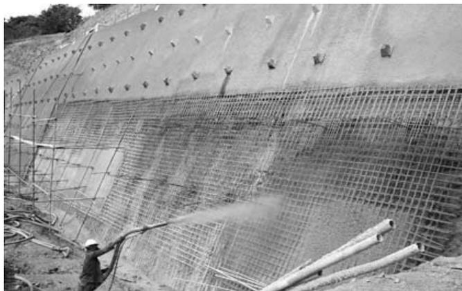
Figura 18 - Exemplo de aplicação de CRF na estabilização de taludes.
